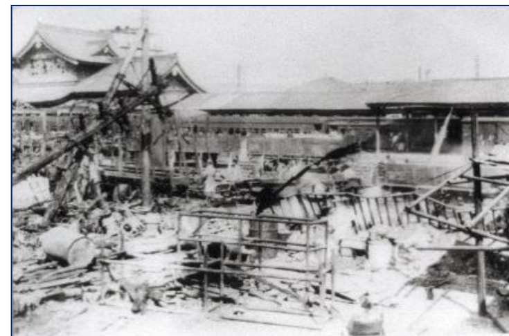
長野工機部被爆跡
